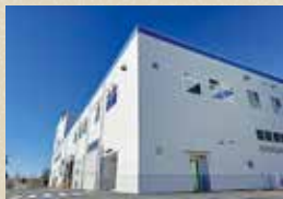
2026年4月1日稼働開始に向けた、茅ヶ崎市環境事業センター粗大ごみ処理施設の建設工事を完了しました
