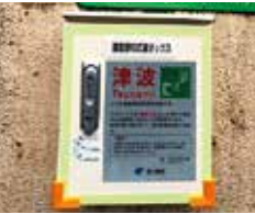
ボックス内に学校施設の鍵、避難経路図などあり
