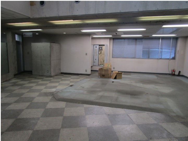
1階ロビー・事務室
