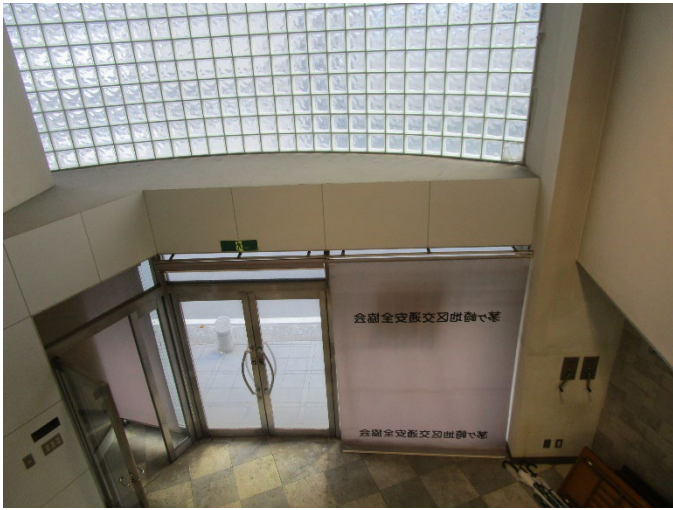
2階通路より撮影（吹抜）
