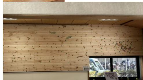
松林公民館の建築廃材を使用して作ったロビー掲示板
