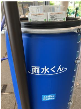
雨水貯留タンク「雨水くん」
