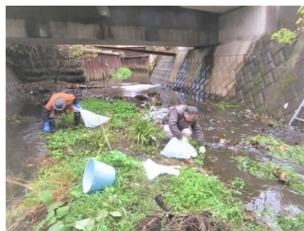
ナガエツルノゲイトウ 除去作業の様子→
