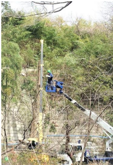
清水谷越境木伐採作業
