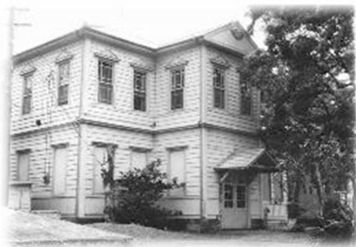
旧南湖院第一病舎の写真
