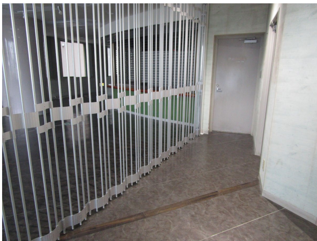
3階エレベーター前ホール（3階・4階・5階共用部分）
