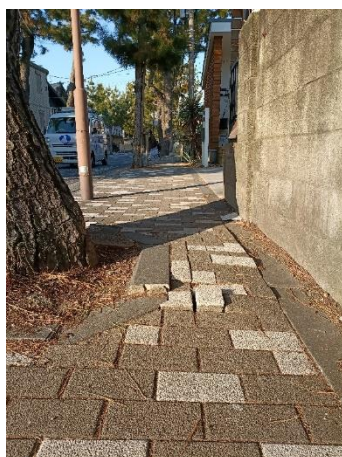
【施工例（東側 No.14）】 施工前
