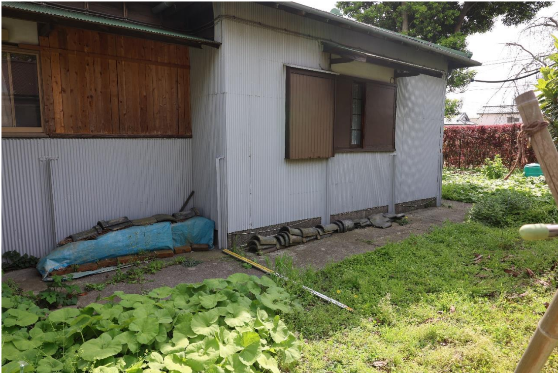
写真2 試掘調査予定地②近景（北東から）
