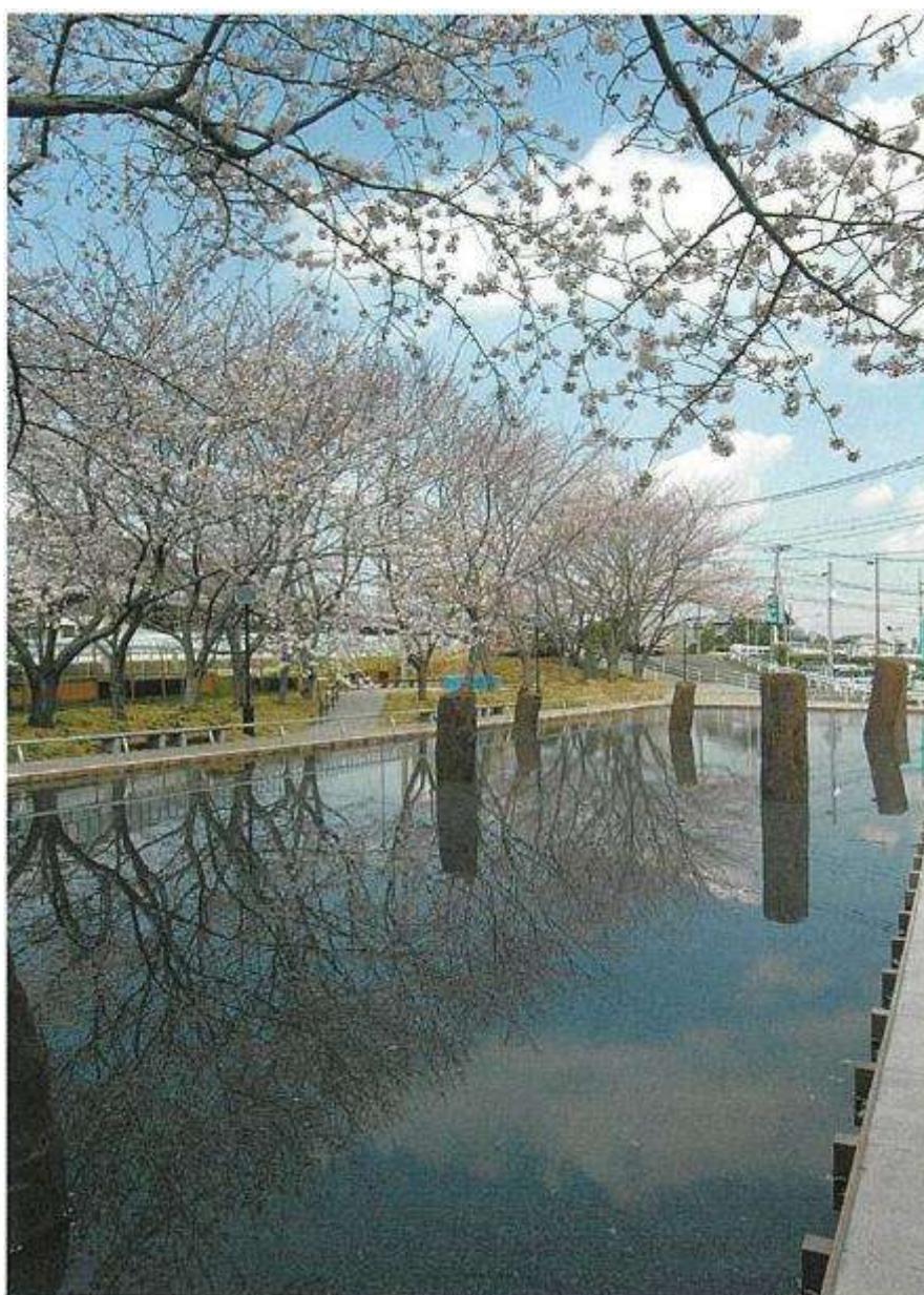
写真 20 保存整備後の旧相模川橋脚
