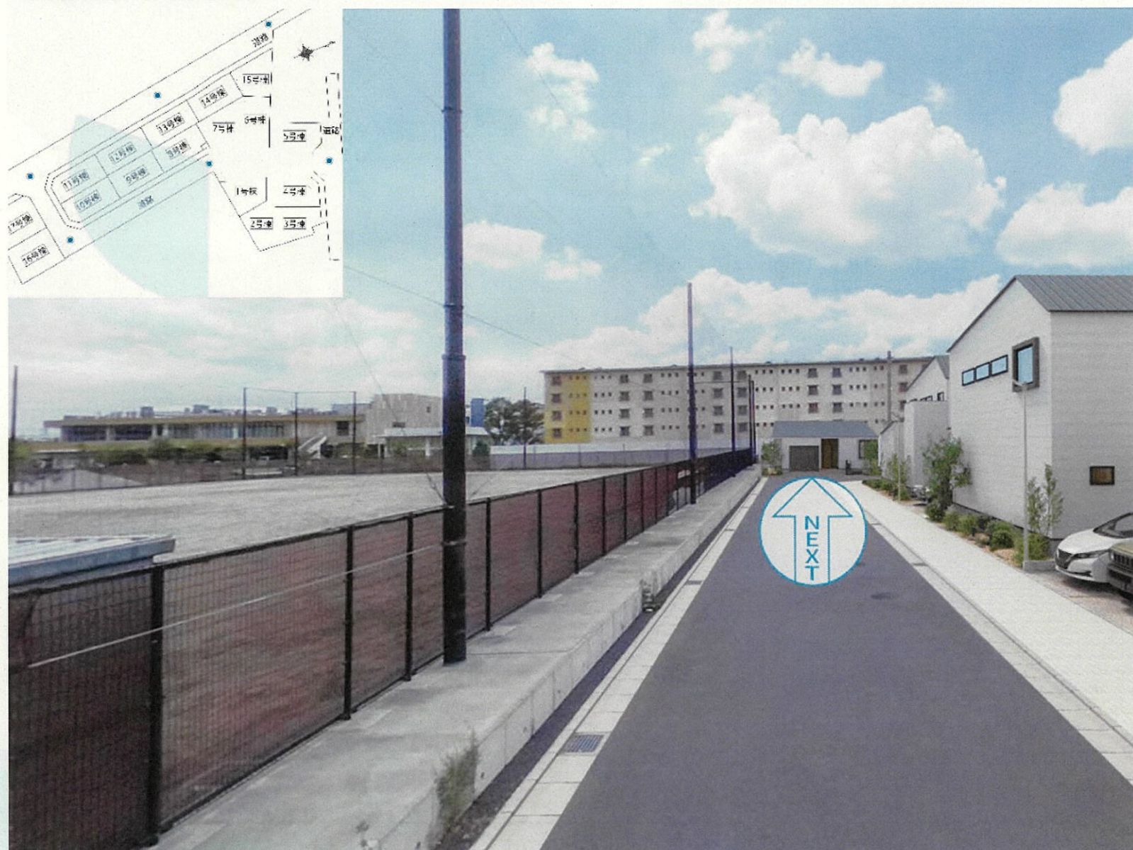
2階建棟中央から平屋棟までの眺め
