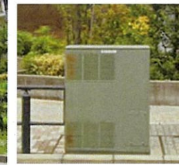
電線地中化に伴う 地上機器イメージ (採用するカラーは ブラウンを想定)
