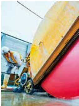
ブレードを高速回転させ、道路や床面を切断
