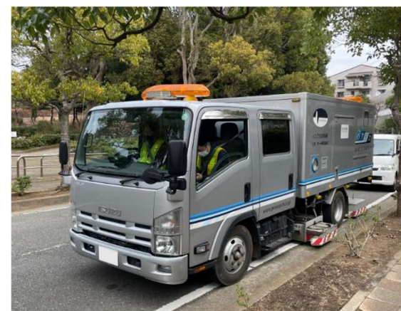
空洞調査（ICT）
