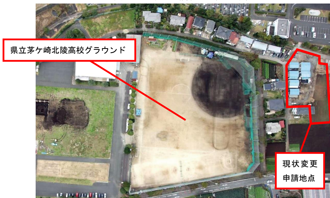
図2 工事地点近景（上が北）
