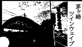
※地下道の屋根部分を改修
