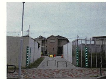
E-3～4区間(通路幅4.0m)、2025年6月24日
