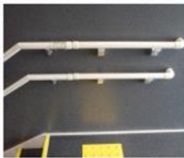
階段手すり延長
