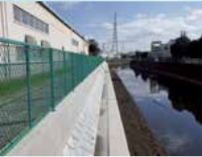
千ノ川の護岸整備
