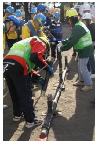
蛇口付き給水管の組み立て
