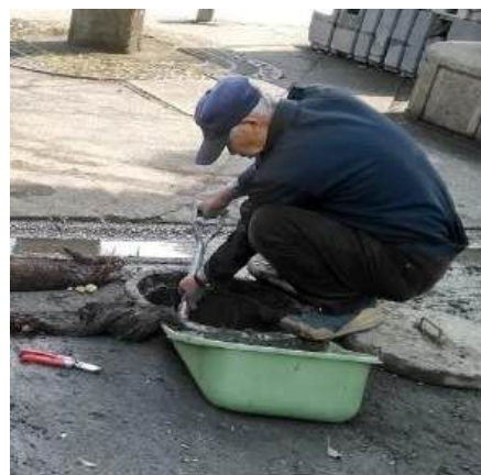
排水路の清掃
