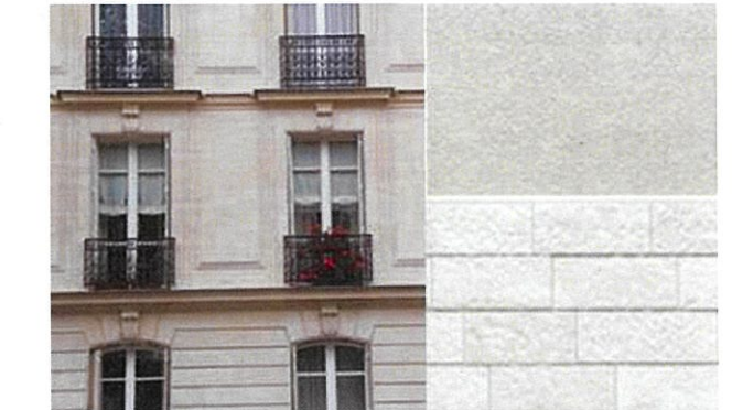
灰白色(かいはいしょく)系漆喰壁の外壁
