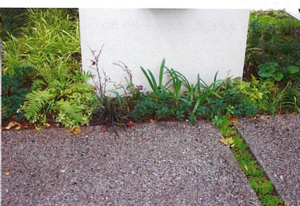
コンクリート舗装洗い出し仕上げイメージ
