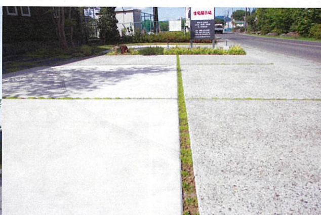
コンクリート舗装洗い出し仕上げイメージ
