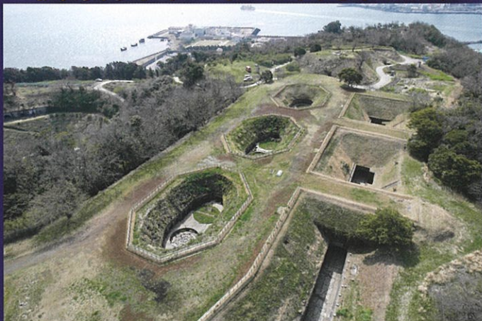
千代ヶ崎砲台跡整備後空撮
