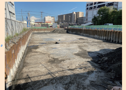
【地盤改良工事】
