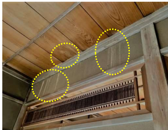
1階天井の雨漏り (→屋根部の雨漏り箇所の補修)
