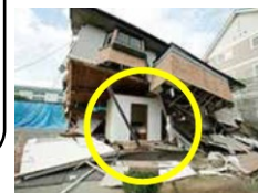
「耐震シェルター」
