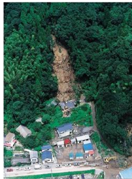
急傾斜地の崩壊
