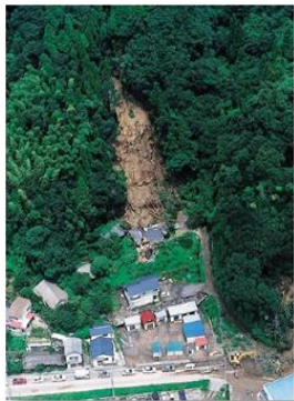
急傾斜地の崩壊
