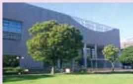
総合体育館のエアコン、エレベーター、トイレを整備
