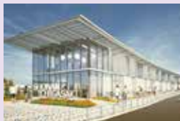
道の駅開設に向けて、設計と周辺を整備
