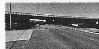
両側の歩道幅が狭い
