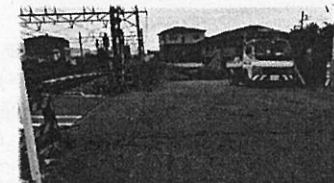
松尾踏切、車両停滞が起こる
