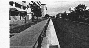
しろやま公園に新設された道路
