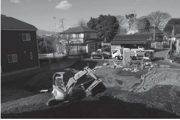
1. 調査地点近景（南東から）
