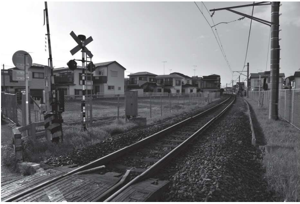
写真1 調査前全景(南東より)
