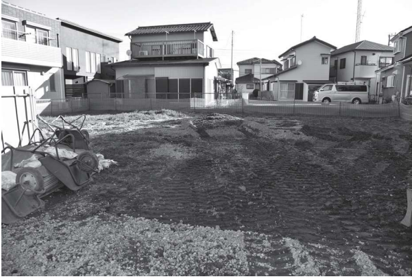
写真1 調査前全景(南西より)
