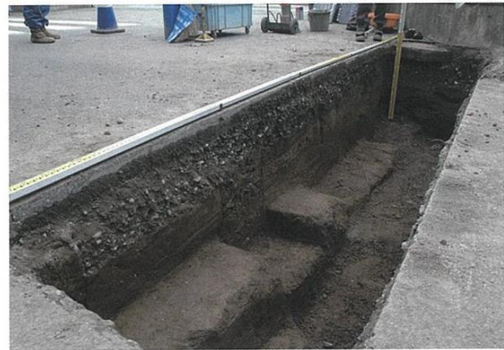
写真4 2トレンチ南 完掘状況[北西から]
