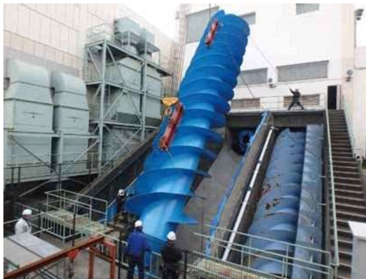
スクルーポンプ据付状況 口径:φ3,000mm 吐出力:196.2m 3 /min
