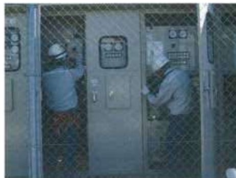
高圧受電設備の点検の様子
