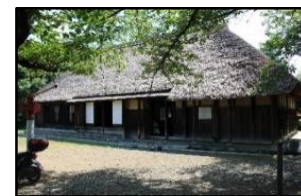
改修工事後の旧和田家住宅
