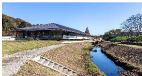
駒寄川工事完成写真
