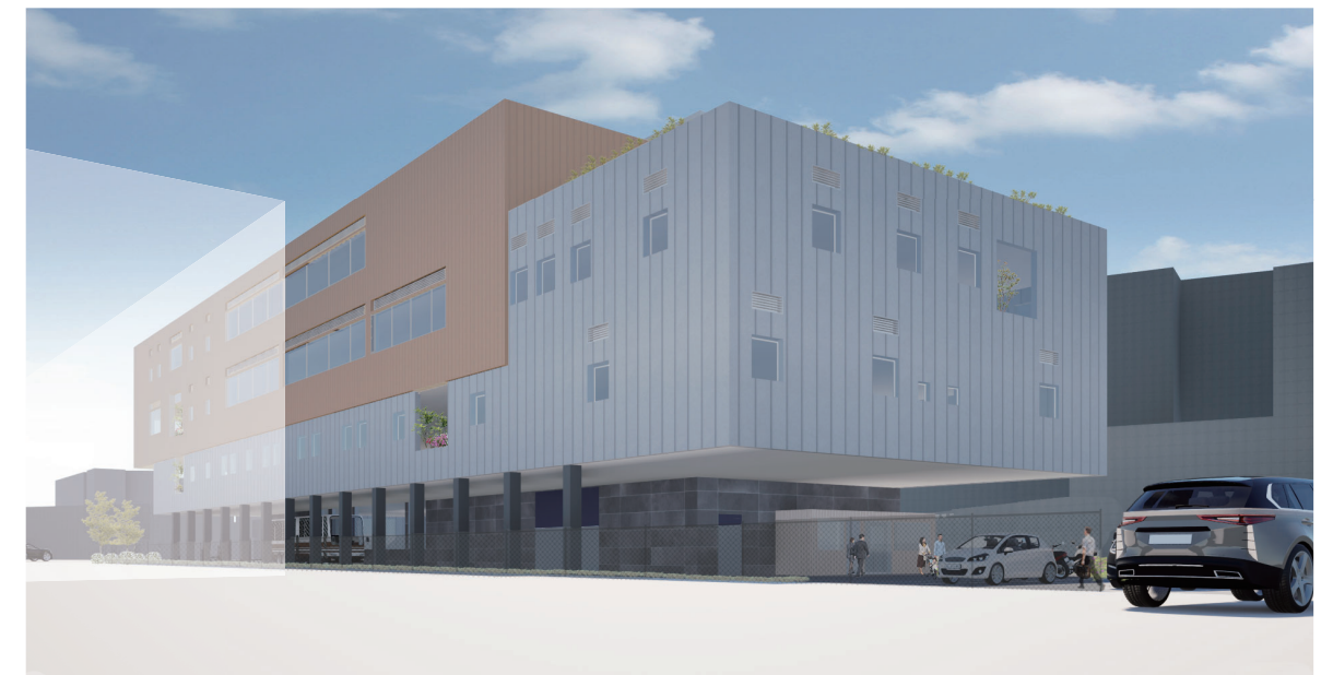
【地域医療センター駐車場からの見え方】
