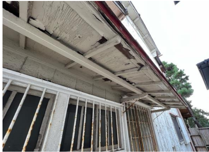
軒裏の補修 (→軒裏の部材入れ替え)
