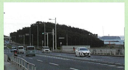
(今)平成3年に4車線化工事が始まり現在に至っています。
