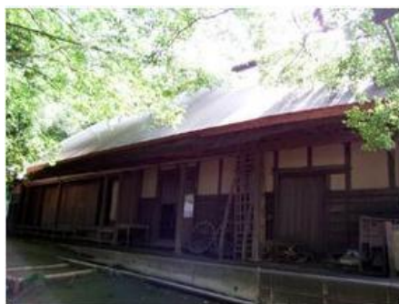
写真 17 旧三橋家住宅
