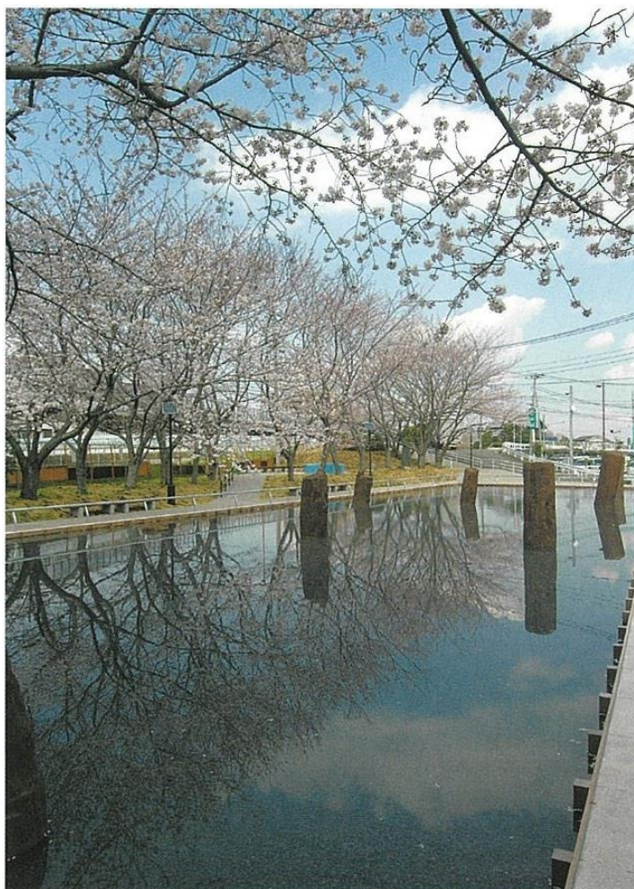
写真 21 保存整備後の旧相模川橋脚
