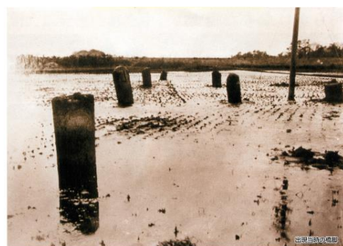
写真12 旧相模川橋脚 出現時の様子
