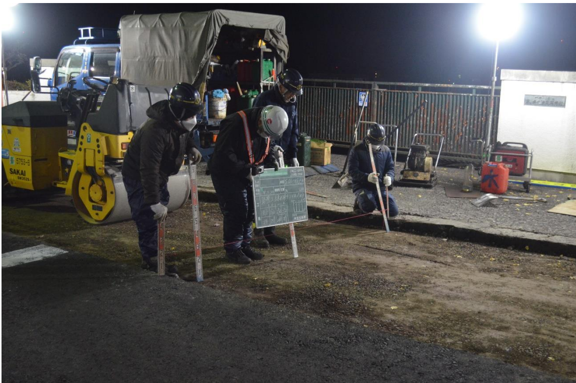
掘削終了状況
