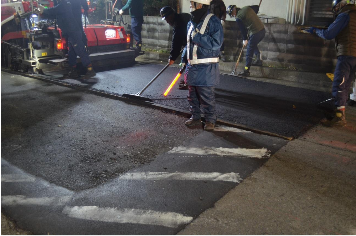
アスファルト復旧状況
