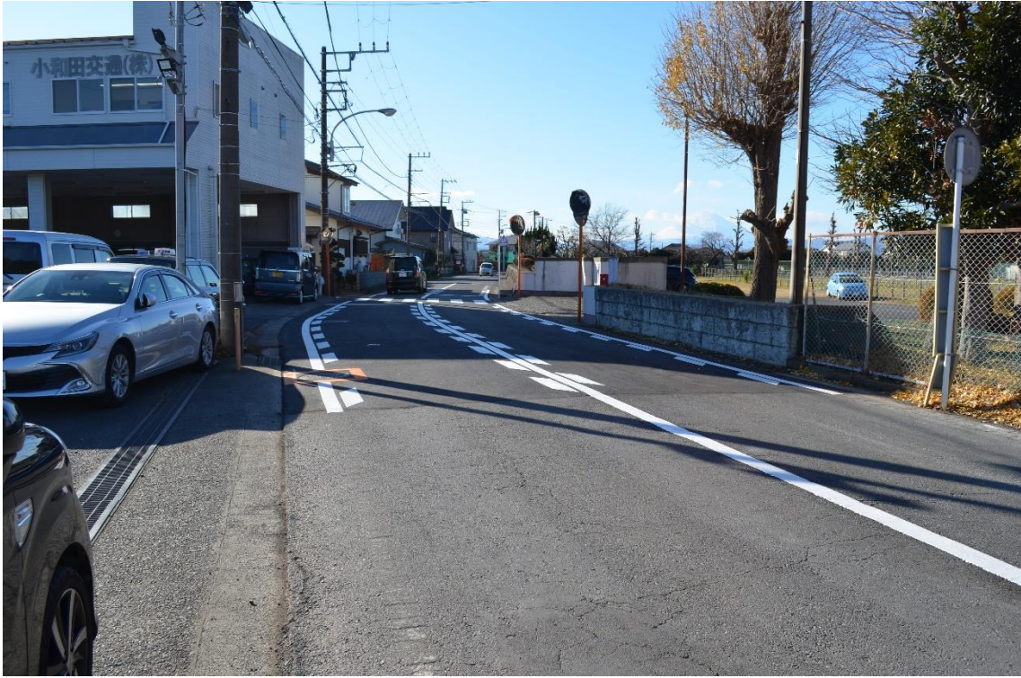
施工後の状況（高校正門前部分）
