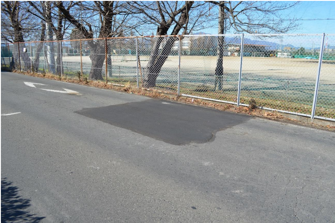
施工後の状況（試掘坑部分）
