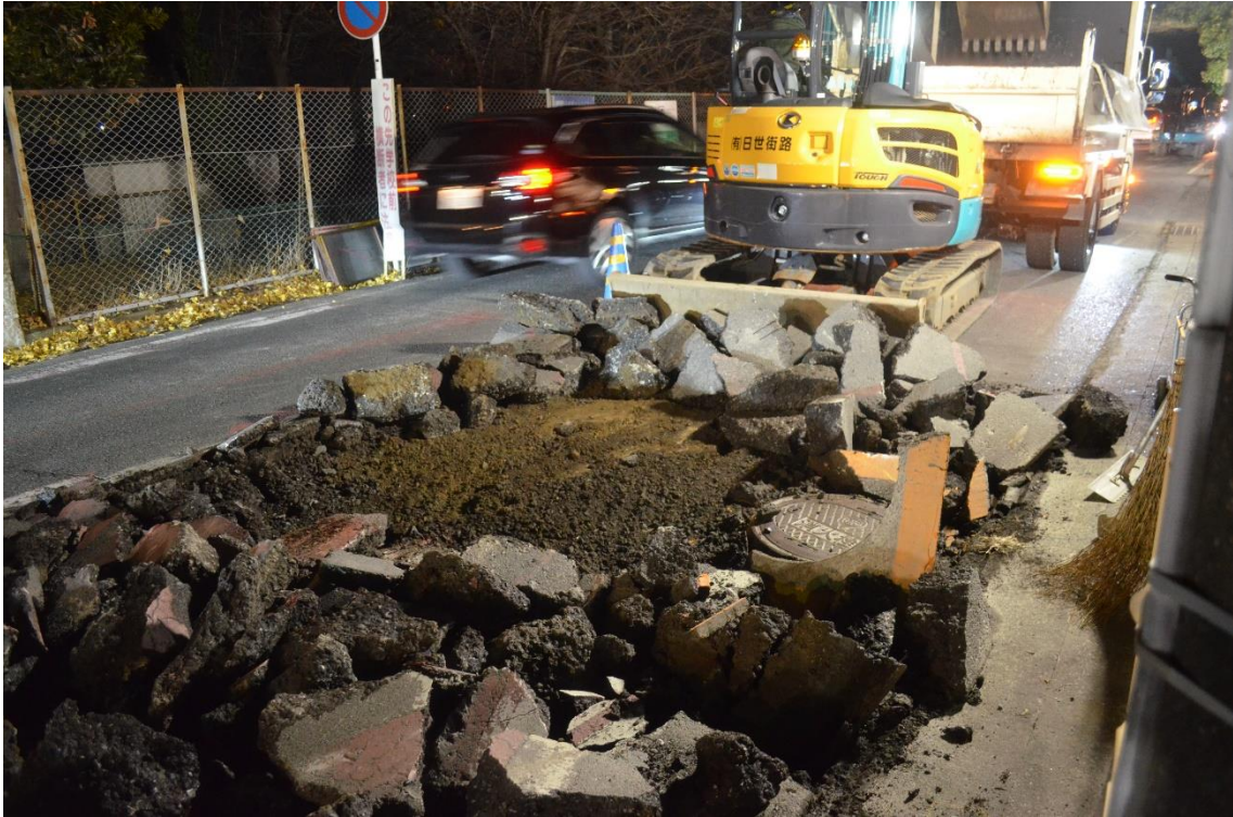
アスファルト撤去作業
