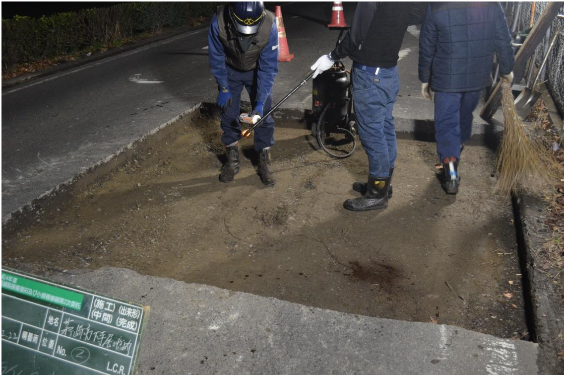
試掘坑部分施工状況
