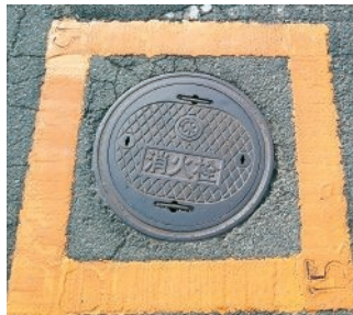
↑消火栓のマンホールは 他にも数種類あります
