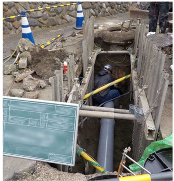
写真 4.4 管路施設改築の様子
