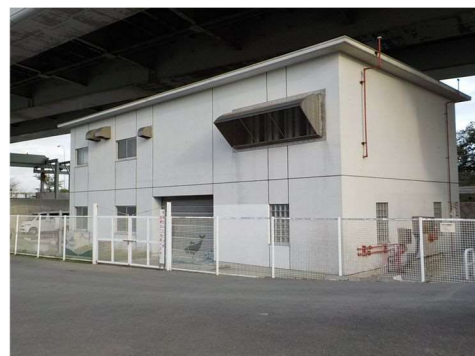
写真 4.6 中島ポンプ場
