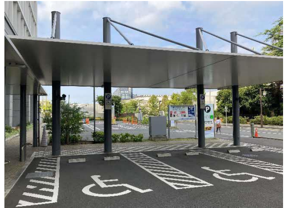
車いす使用者用駐車施設から主要な出入口までの経路に屋根を設置【茅ヶ崎市役所】
