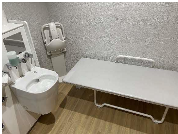
大型ベッドのある車いす使用者用トイレ【うみかぜテラス】
