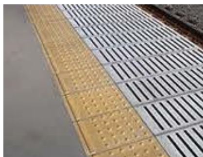
図 内方線付点状ブロック
