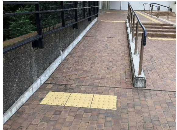
出入口手前に設置されたスロープ【茅ヶ崎市民文化会館】
