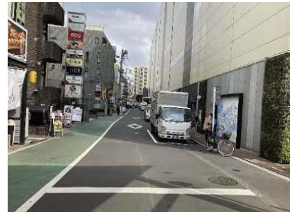
図 安全対策(カラー舗装化)
