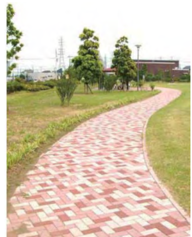
写真 整備イメージ (インターロッキング舗装の事例)
