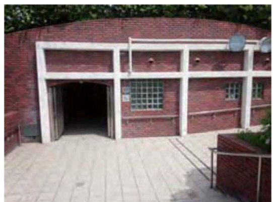
写真 現況のトイレ
