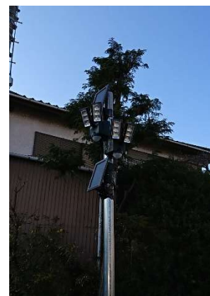
写真2 単管設置イメージ
