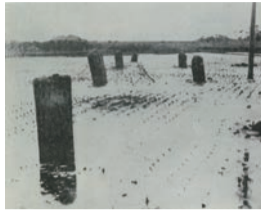
関東大震災で水田から出現した橋脚(1924年撮影)
