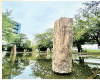
関東大震災のとき、水田から橋脚が出現。現在は保存のため埋め戻し、その上にレプリカを設置
