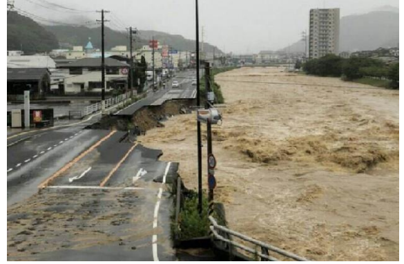
写真提供：国土交通省中国地方整備局
