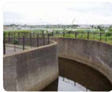
雨水排出口(柳島)
