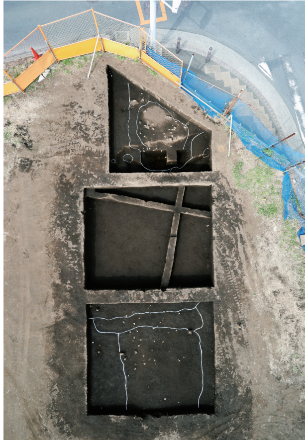
A、B、D区空撮（上が北）
