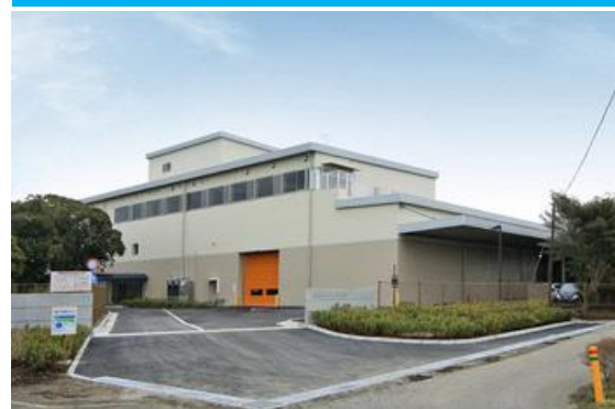
寒川広域リサイクルセンター
