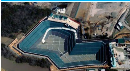
堤十二天一般廃棄物最終処分場
